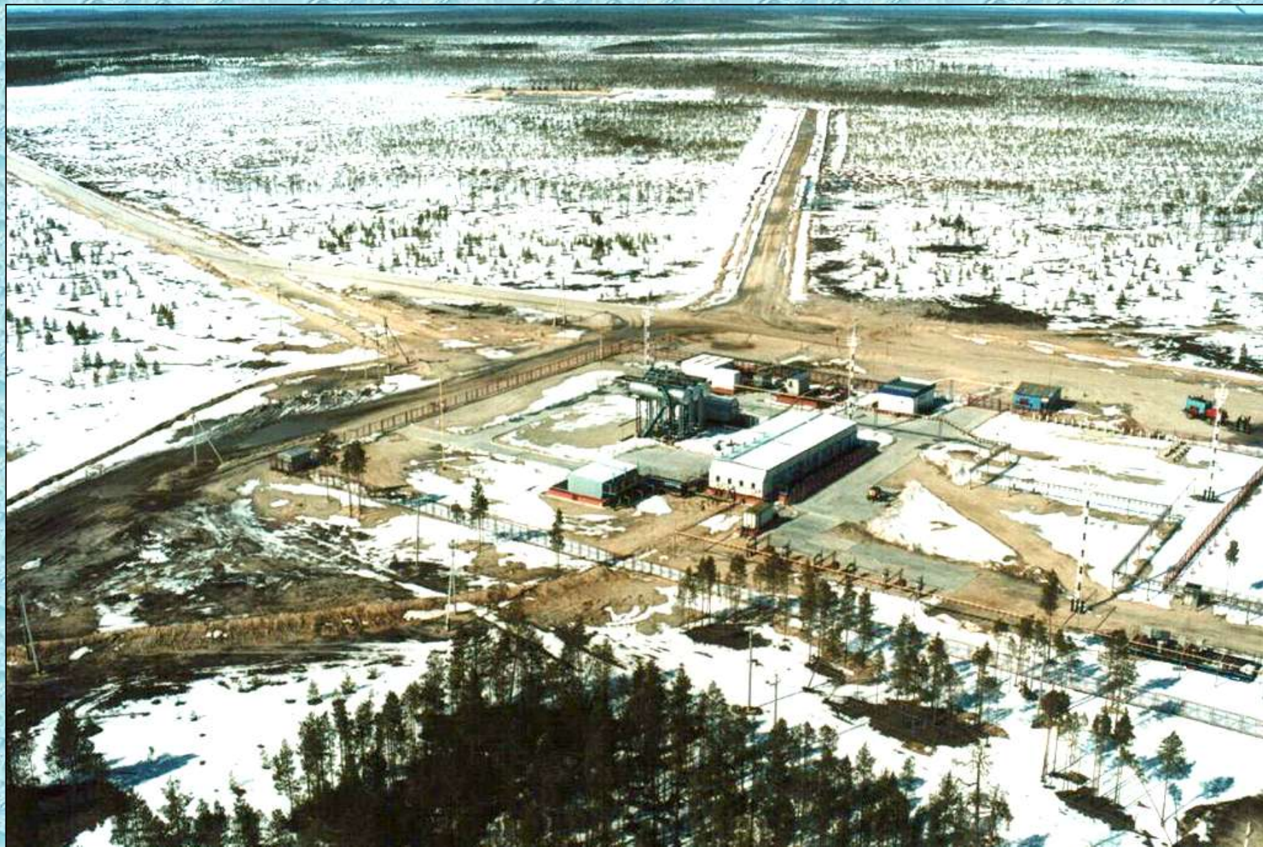
Водозабор на ДНС «Тальниковая»
