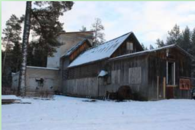
Здание шишкосушки Калининского типа
